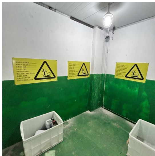
内部设有托盘，做到防腐防渗、同时设有分类标识牌、防爆灯、监控
