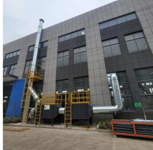
机制板废气处理（二级活性炭+15m 高 1#）
